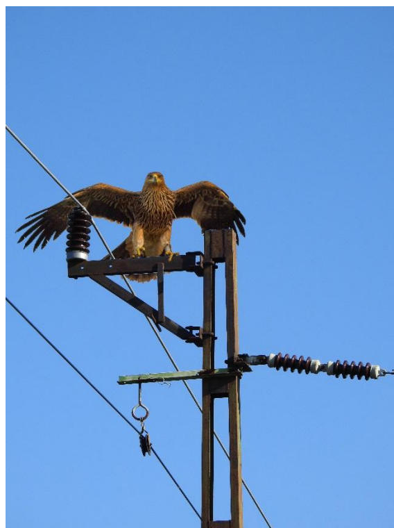
7. ábra: Az oszlopcsúcsra, vagy a tápvezeték tartóbakra kiülő madár a leszálláskor és elrugaszkodáskor is könnyen hozzáérhet a tápvezetékhez
