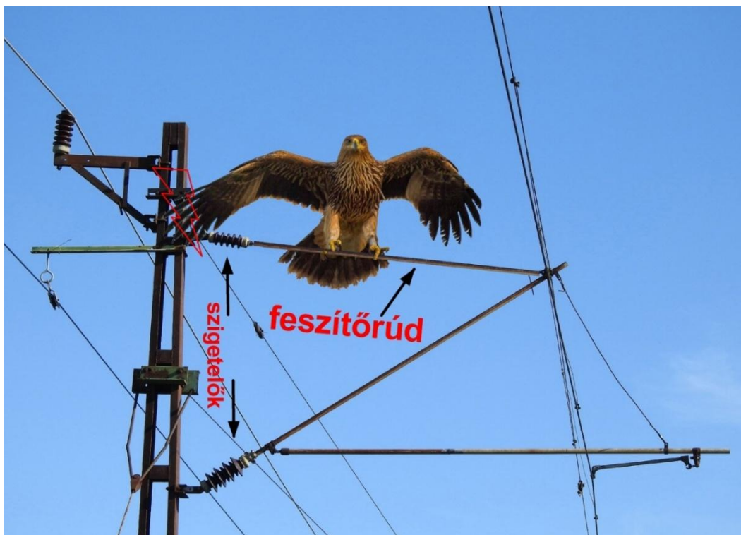
2. ábra: A feszítórúdra kiülő nagytestű ragadozómadár a méretei miatt könnyen rövidre zárhatja az áramkört
