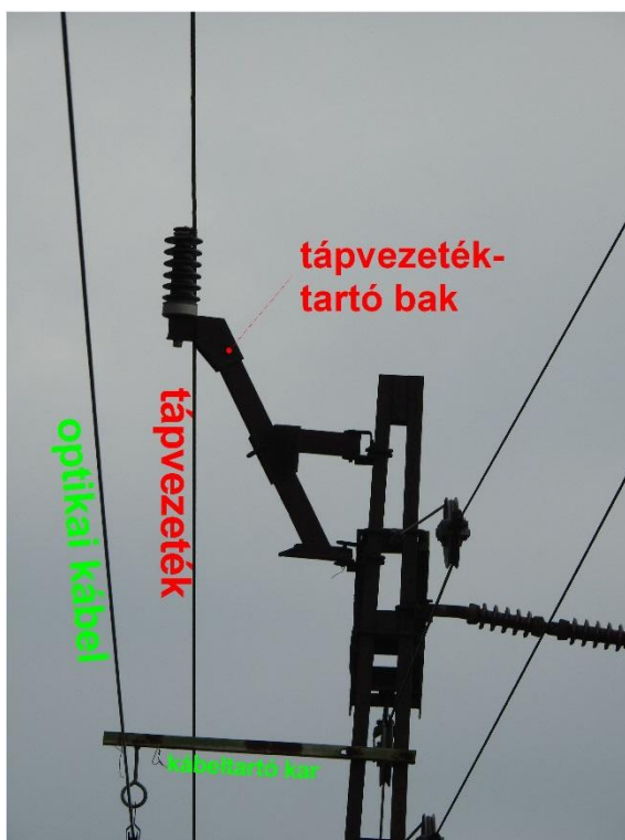
6. ábra: A fázispontenciálú tápvezeték, valamint a földpotenciálú szerkezeti elemek, mint a tápvezeték tartóbak, oszlop, kábeltartó kar. Az oszlopcsúcsra kiülő madár a leszálláskor és elrugaszkodáskor is könnyen hozzáérhet a tápvezetékhez
