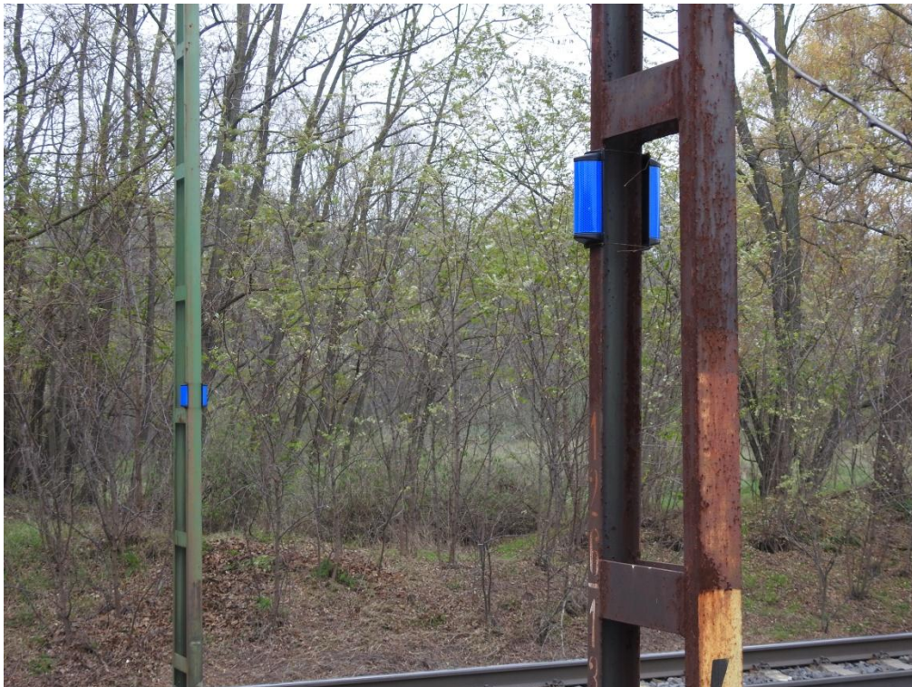
14. ábra: RIBE típusú, madárvédelmi szempontból kedvező műszaki kialakítású, nagy élettartamú, karbantartást nem igénylő láthatósági eszköz, amely a Budapest – Belgrád vasútvonalon (150. sz.) már több szakaszon is telepítésre került
