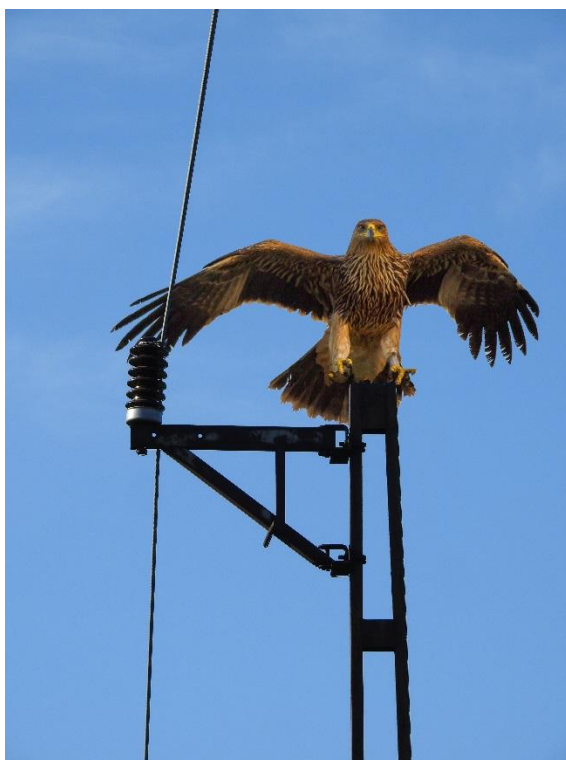
7. ábra: Az oszlopcsúcsra, vagy a tápvezeték tartóbakra kiülő madár a leszálláskor és elrugaszkodáskor is könnyen hozzáérhet a tápvezetékhez
