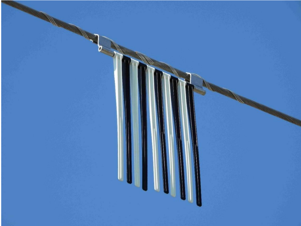
14. ábra: RIBE típusú, madárvédelmi szempontból kedvező műszaki kialakítású, nagy élettartamú, karbantartást nem igénylő láthatósági eszköz, amely a Budapest – Belgrád vasútvonalon (150. sz.) már több szakaszon is telepítésre került
