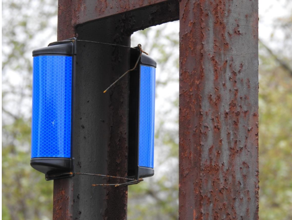
16. ábra: Kékfóliás optikai vadriasztó prizma az 1 számú, Budapest–Hegyeshalom–Rajka vasútvonalon, Nagyszentjános és Győrszentiván között, Cuha-Bakonyér keresztezési pontjánál
