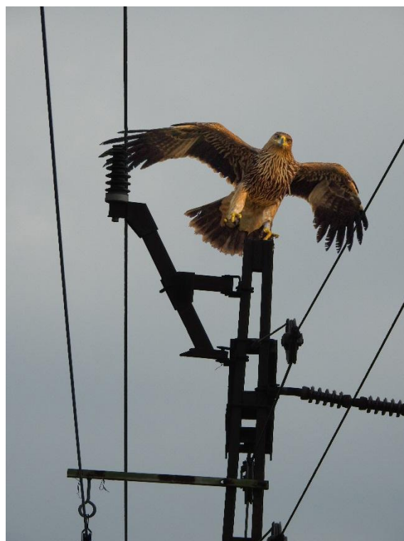
6. ábra: A fázispontenciálú tápvezeték, valamint a földpotenciálú szerkezeti elemek, mint a tápvezeték tartóbak, oszlop, kábeltartó kar. Az oszlopcsúcsra kiülő madár a leszálláskor és elrugaszkodáskor is könnyen hozzáérhet a tápvezetékhez
