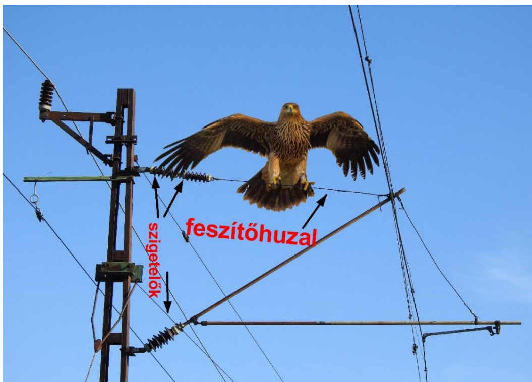
3. ábra: Feszítőhuzal, vagy feszítő sodrony és hosszabb szigetelő alkalmazása esetén azonban lényegesen csökken az esélye nagytestű madarak áramütésének. A huzalra (sodrony) nem szívesen ül nagy testű madár
